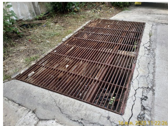
รูปถ่ายที่ 3.2-10 : บ่อและตะแกรงดักขยะ
