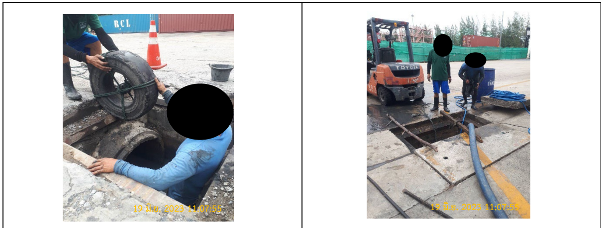
รูปถ่ายที่ 3.2-19 (ต่อ) : การขุดลอกตะกอนดินจากท่อระบายน้ำ
